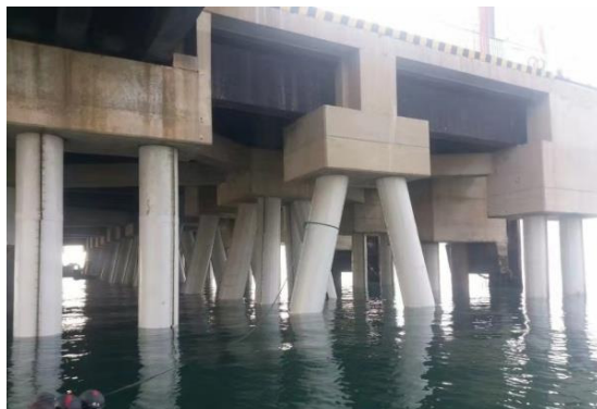
图 15 大连北良港石化码头钢桩包覆实例(2019 年完成)
