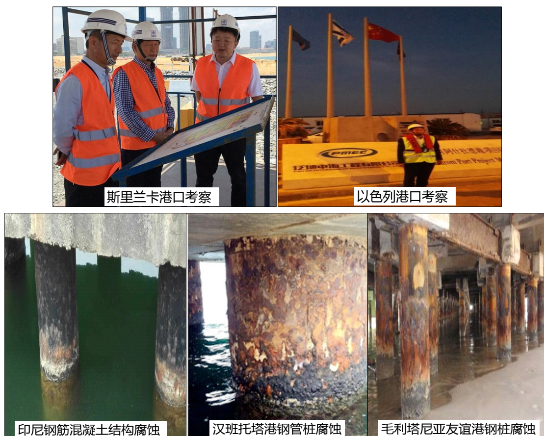
图 17 “一带一路”沿线国家港口海洋钢结构及钢筋混凝土结构考察情况
