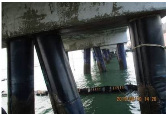
图 14 青岛港液体化工码头钢桩 12 年后包覆(左)和未包覆(右)腐蚀情况
