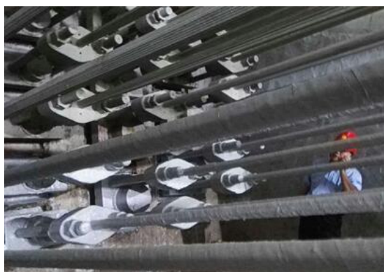
图 16 复层矿脂包覆技术在桥梁锚碇防腐蚀中的应用,防护前(左)和防护后(右)
