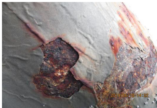
图 14 青岛港液体化工码头钢桩 12 年后包覆(左)和未包覆(右)腐蚀情况
