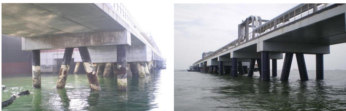
图 12 青岛港液体化工码头钢桩包覆前(左)和包覆后(右)
