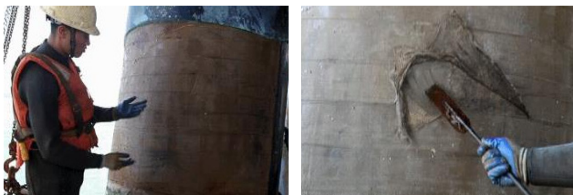
图 13 青岛港液体化工码头示范钢桩现场验证
