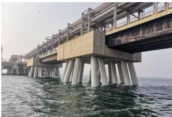
图 15 大连北良港石化码头钢桩包覆实例(2019 年完成)
