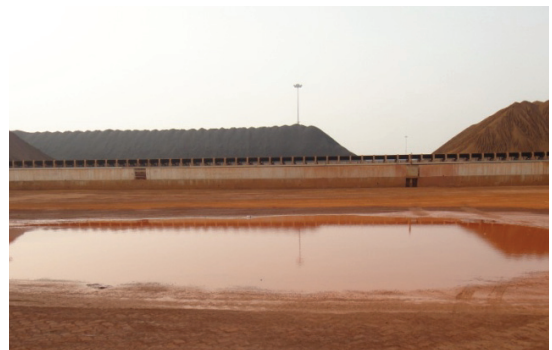
图 1 某矿石码头堆场积水情况
