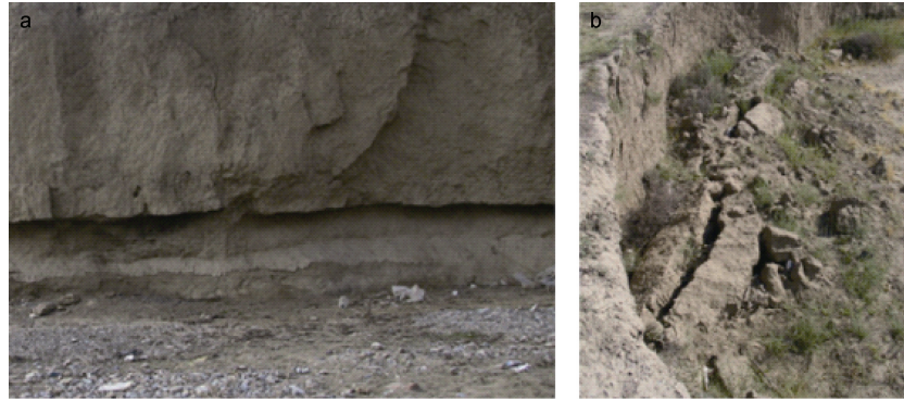
图 1 侧向流冲刷形成悬臂及边壁崩塌
