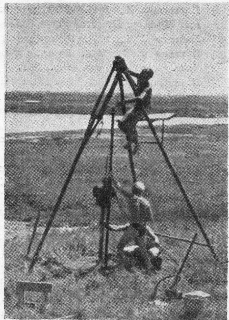
圖 15. 在陆地上工作的振动活塞式取样管。
